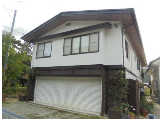
事務所 (居室・キッチン・風呂・トイレ付き)
