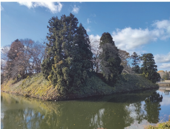
二ノ丸北東出隅部堀土塁
