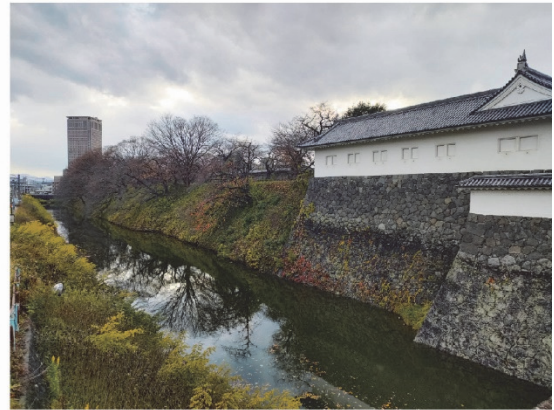
二ノ丸東大手門石垣と二ノ丸東堀土塁（南部）
