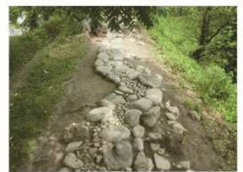
二ノ丸北部・土塁天端屏風折土塀礎石検出状況
