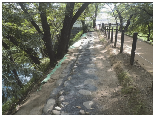
ニノ丸東土塁天端（土塀礎石列）復旧状況
