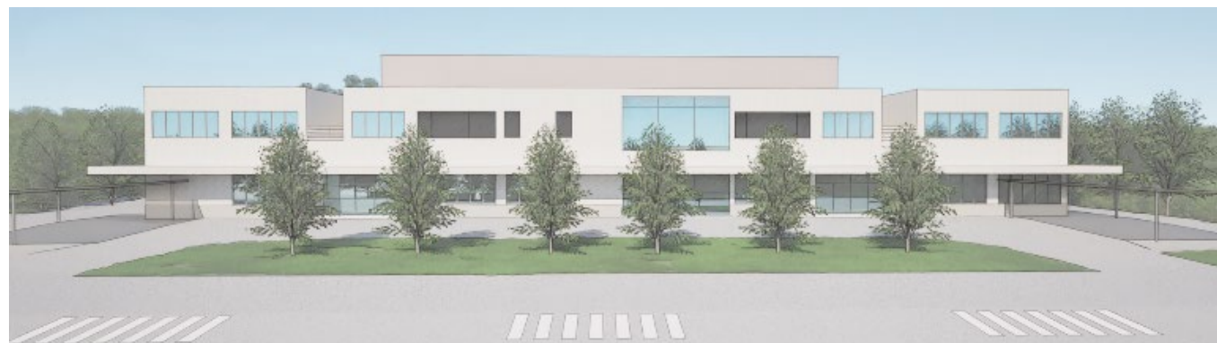
図 14 入口正面の外観イメージ
