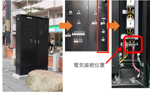
分電盤① (右は開けた状態) 200V最大45A ※分電盤②と同回路 / 100V使用不可 コンセントなし/要電気工事
