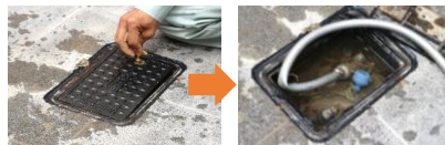
散水栓 (右は蓋を開けた状態) ※呼び径13mm
