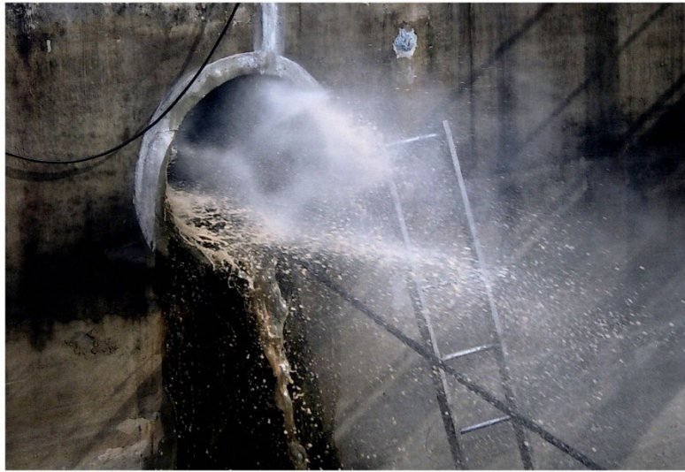
図 11.3.2-39 浸出水集排水管（浸出水調整槽側開口部）の高圧洗浄作業写真 （撮影日：令和6年10月16日）
