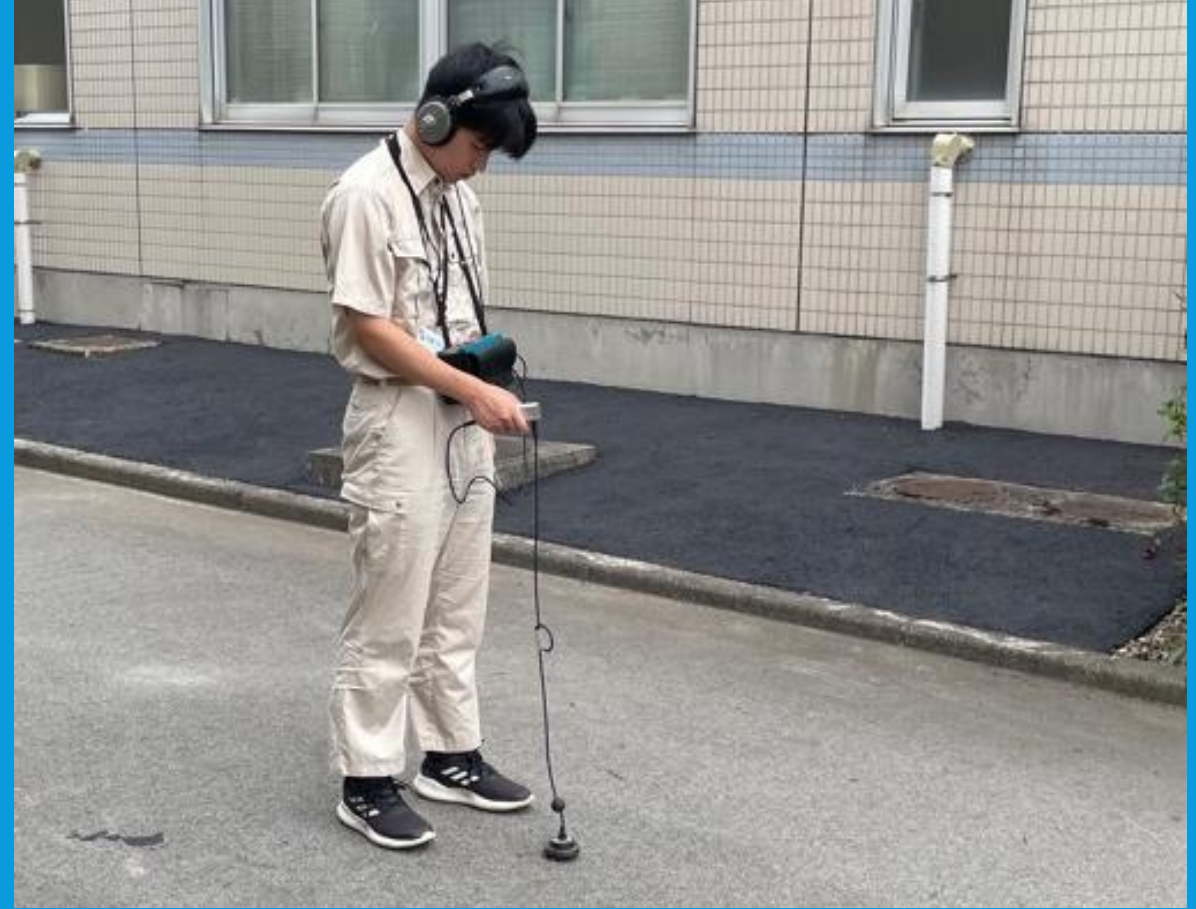
漏水調査 (音聴による現場調査)
