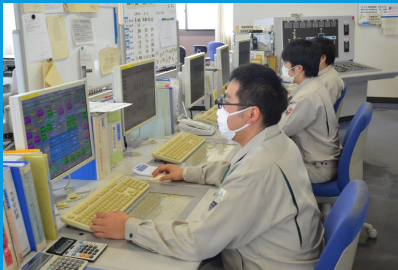
中央監視室（見崎浄水場）
