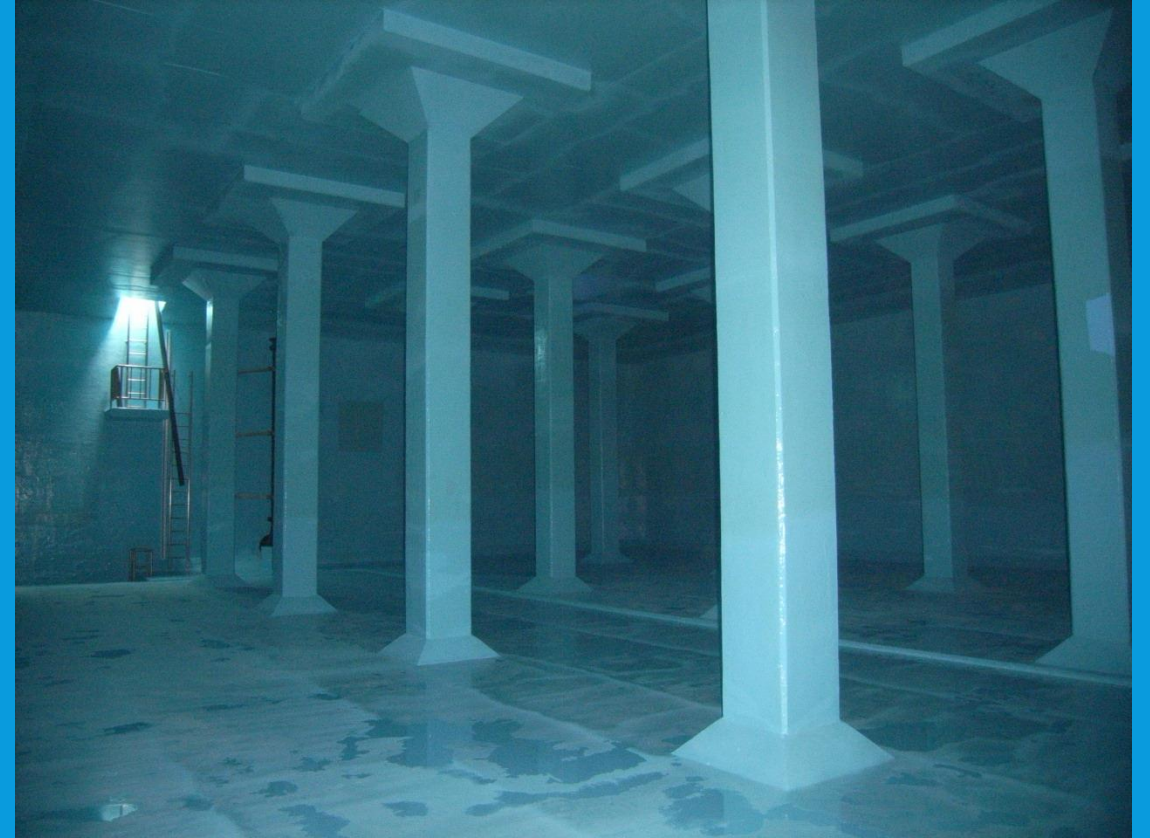
耐震化施設（南山形配水場）
