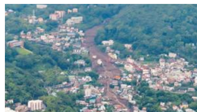
▲令和3年7月の静岡県熱海市で発生した土石流災害の様子。危険な盛り土などによる被害が全国で発生しています。
