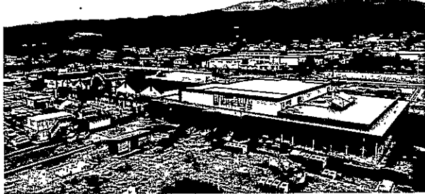
「道の駅やまがた蔵王設計建設工事共同企業体提供」
