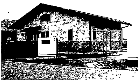
「平成12年3月 施工漆房処理施設」
