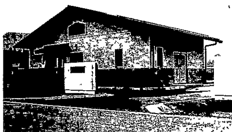
「平成12年3月 施工漆房処理施設」
