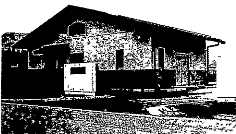
「平成12年3月 施工漆房処理施設」
