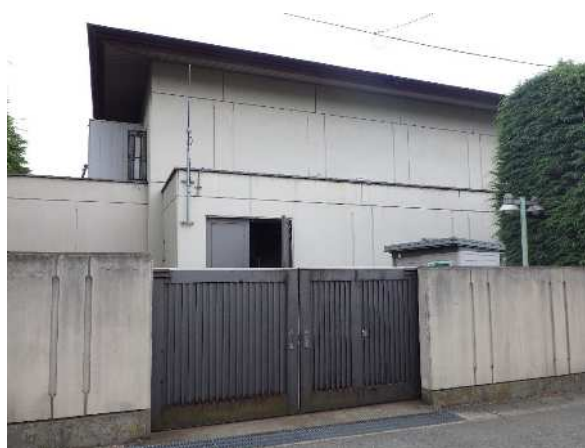
写真 6. 従業員出入口
