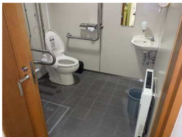
写真 35. 身障者用トイレ
