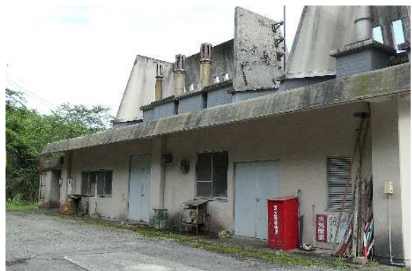
写真 16. 排気筒（斎場北側）
