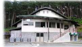
▲板橋沼キャンプ場 管理棟
