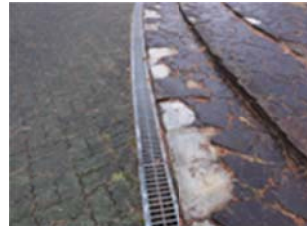
石張舗装の部分的剥離
