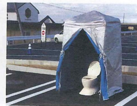
マンホールトイレ
