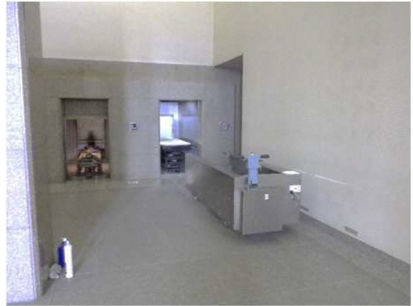
写真 12. 炉前ホール（5号火葬炉・大型炉前）
