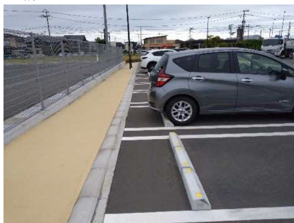
カラー舗装（大崎市 道の駅大崎）
