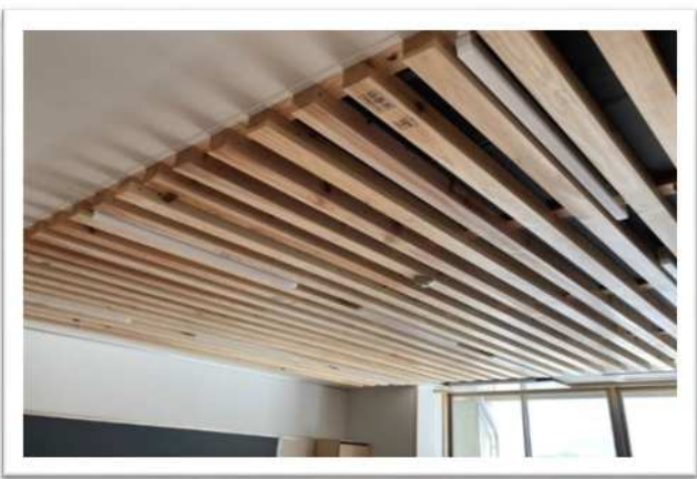
・天井の一部に使用
