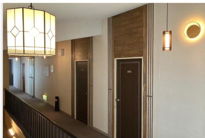
客室入口の入り口に使用
