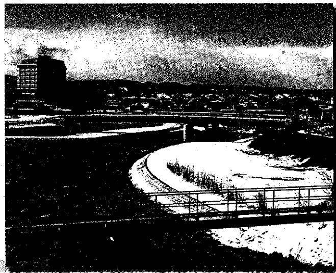
村山高瀬川の河川整備と青柳橋の架け替え工事が行われています。
