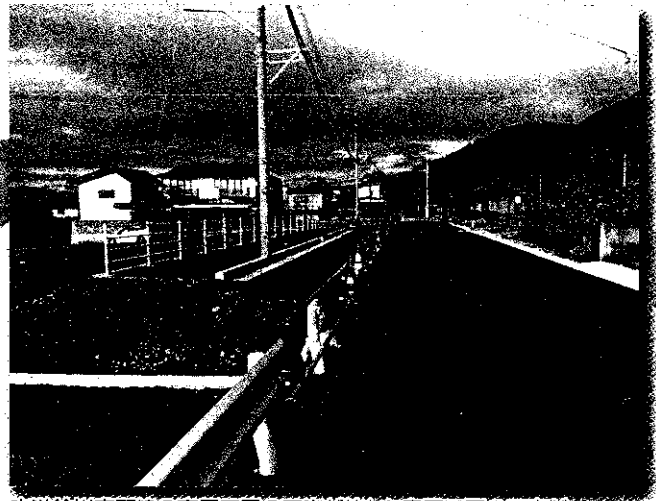
市道鈴川青野線の高原工区の工事が終わり青野工区の工事が始まりました。
