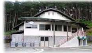
▲板橋沼キャンプ場 管理棟
