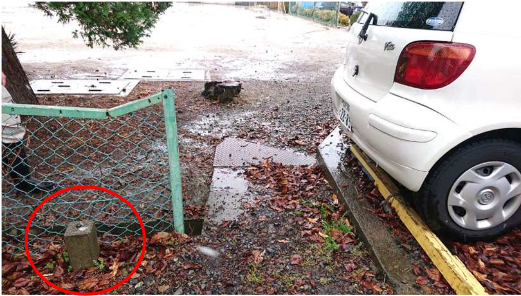
法定外公共物（水路）と民地（1177-1）の境界部分写真 ※A'3257C箇所
