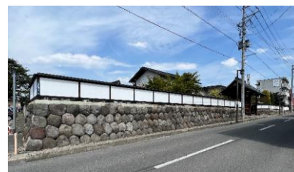
図 2-33 七日町に残る丸石積み
