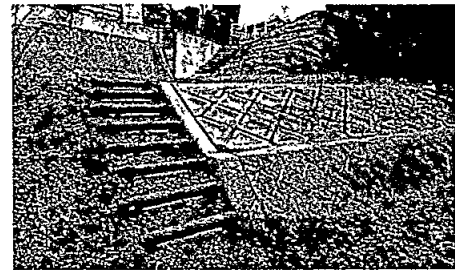
河川敷階段、防草シート 設置 (南二番町)
