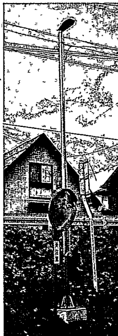
桜田西 街路灯設置
