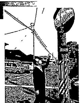
カーブミラー設置
