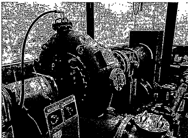
蔵王ダムの水エネルギーを利用した小水力発電施設
