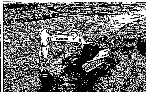
河川管理掘削工事
