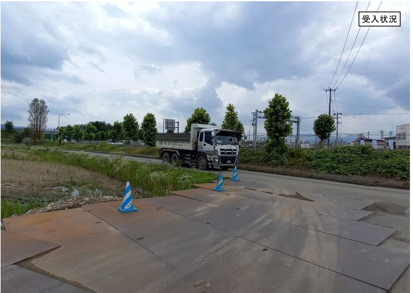
国道13号法面 伐採状況
