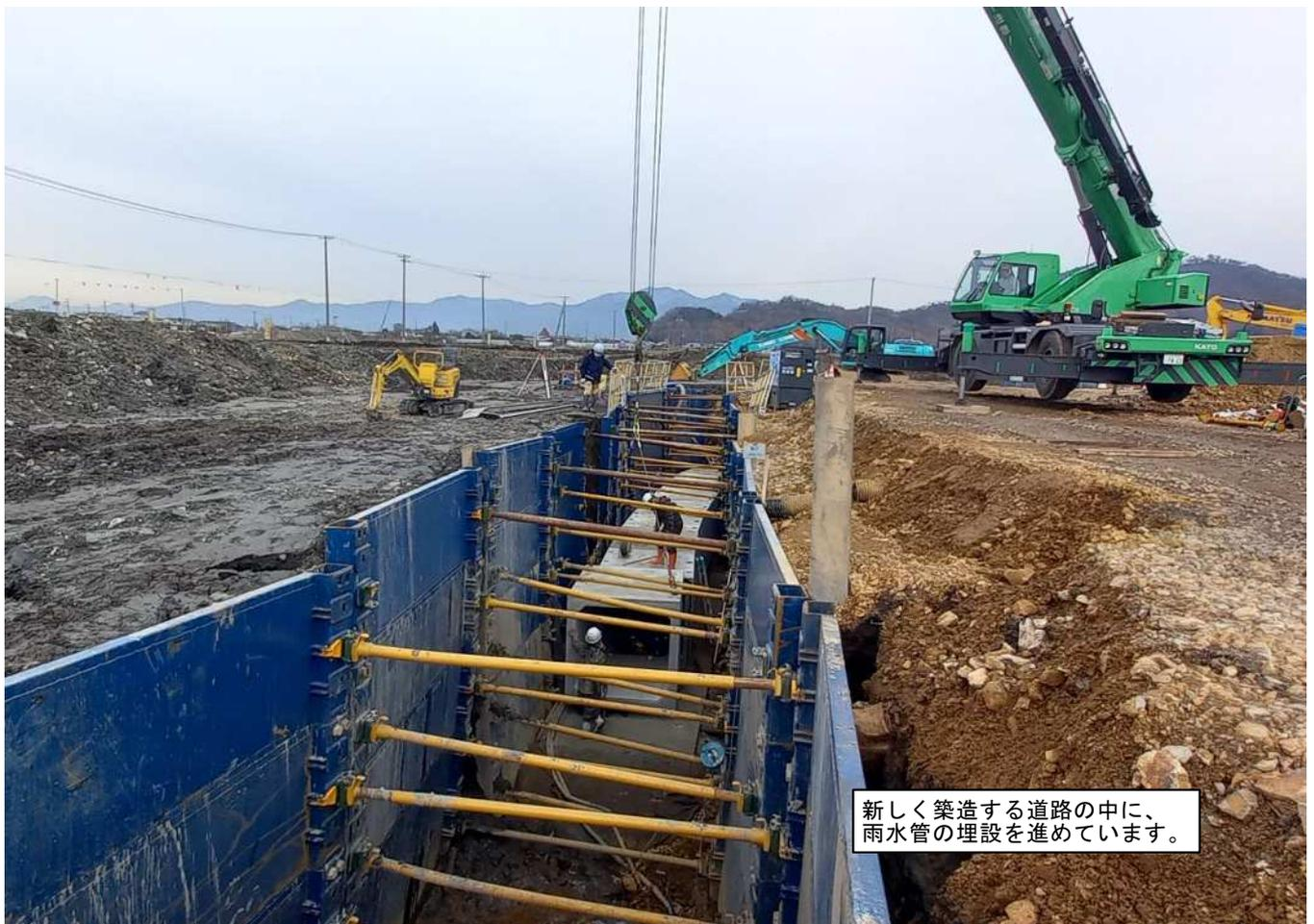
新しく築造する道路の中に、雨水管の埋設を進めています。
