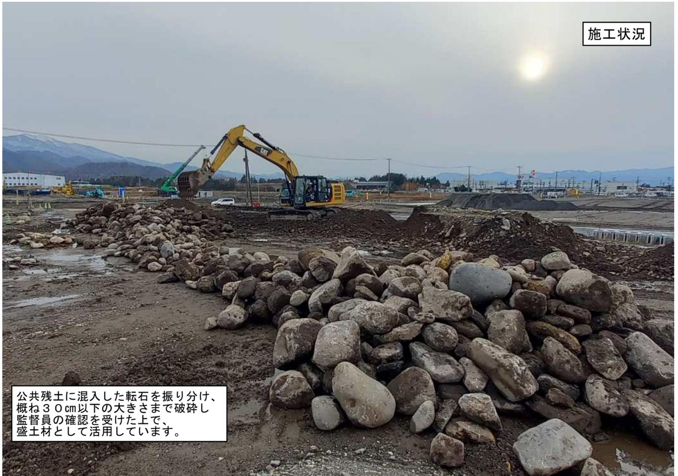
公共残土に混入した転石を振り分け、概ね30cm以下の大きさまで破碎し、監督員の確認を受けた上で、盛土材として活用しています。
