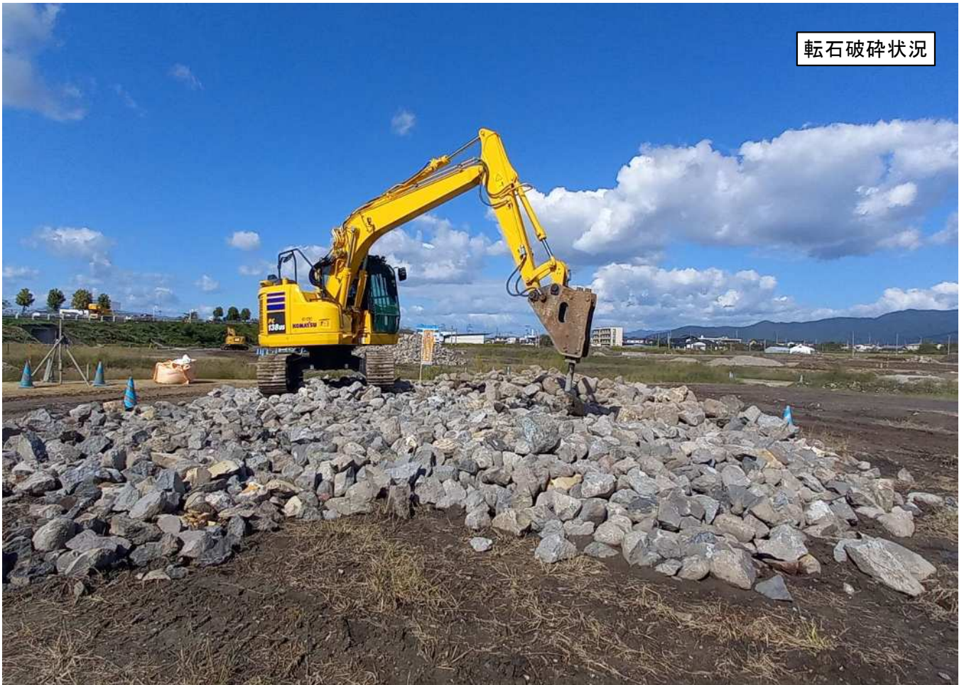
転石破碎状況
