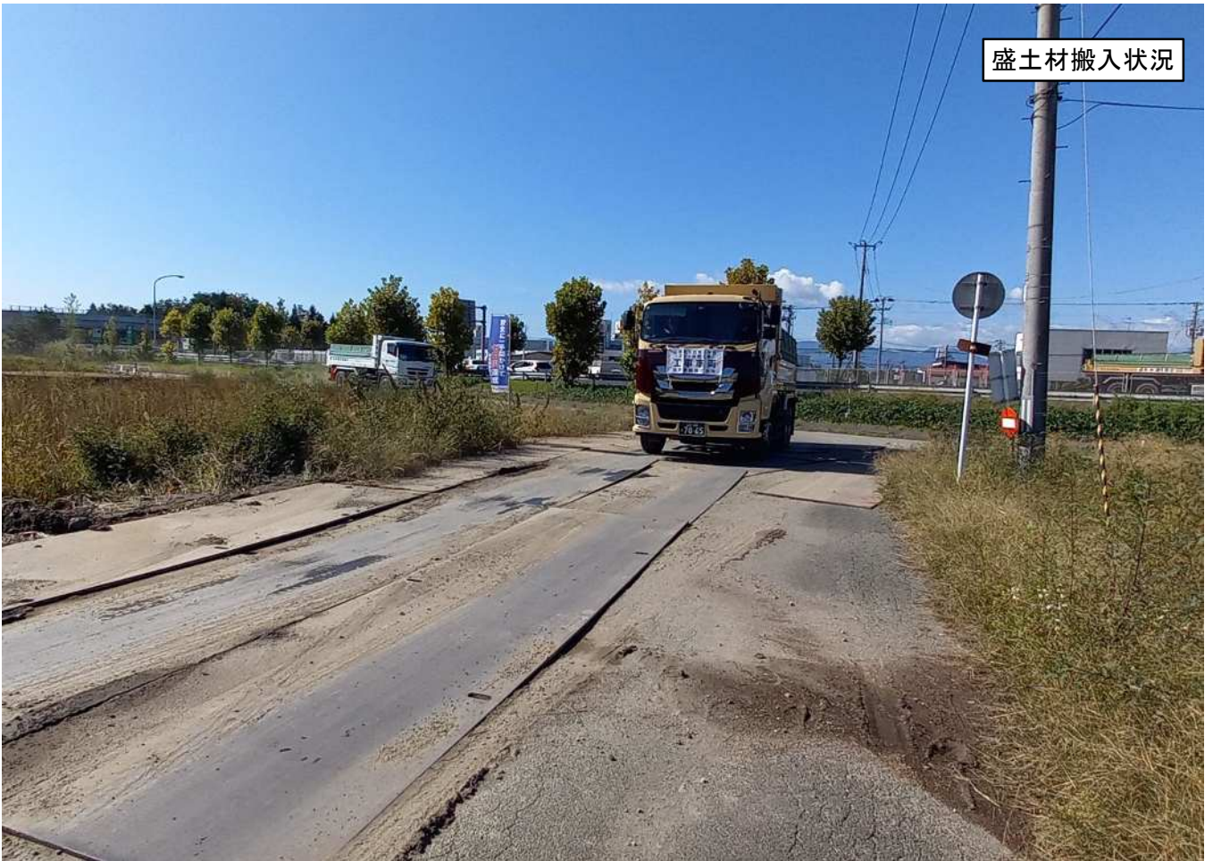
盛土材搬入状況
