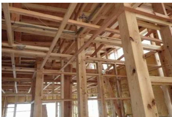
【家づくり事業】 建築現場
