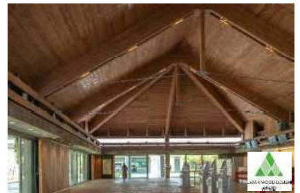
みやこ下地島空港ターミナル (沖縄県宮古島市)
