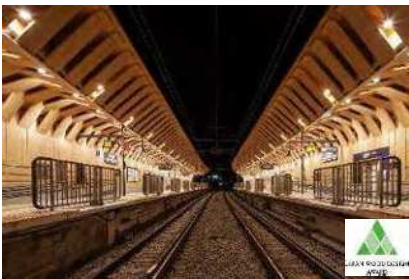
東急池上線戸越銀座駅 (東京都品川区)
