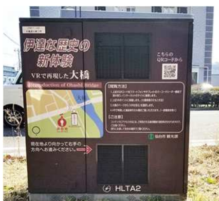
(7)路上変電塔にはり紙（ラッピング）
