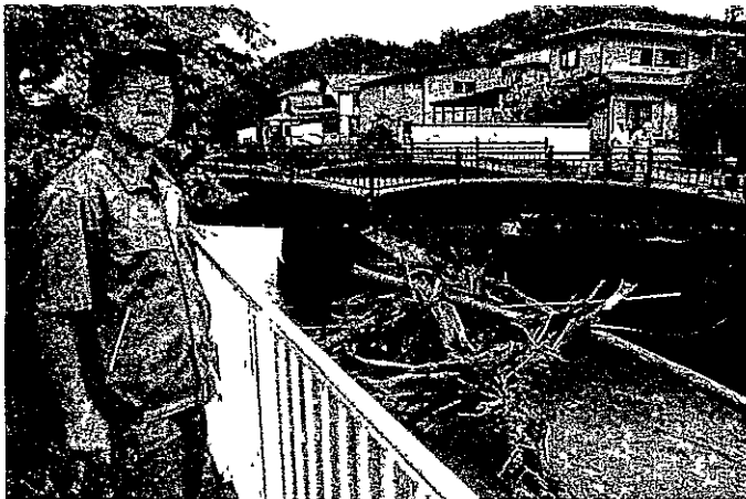
はしげたが崩壊し、架け替えが決まった本沢橋
