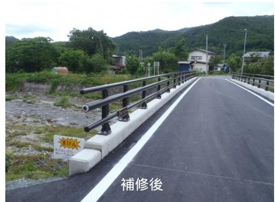
写真．地覆・防護柵の補修事例
