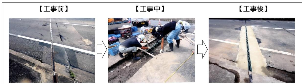
写真．予防的な対策事例（伸縮装置の非排水化）
