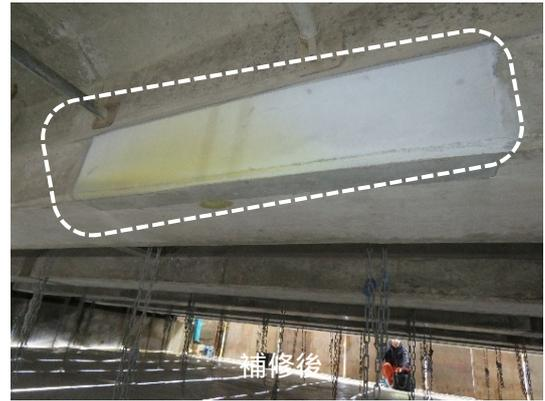
写真．コンクリート橋の補修事例
