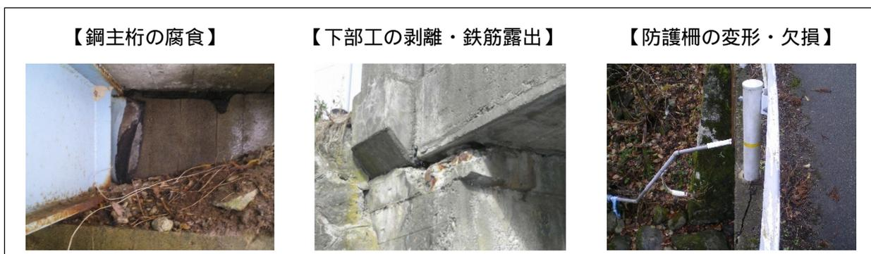
写真．著しい損傷
