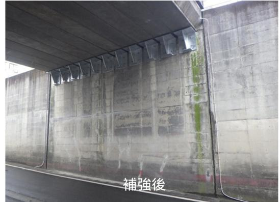
写真. 耐震補強事例
