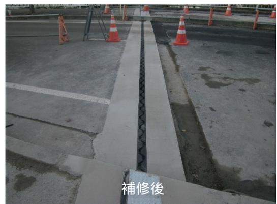
写真．伸縮装置の補修事例
