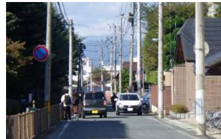
電柱により妨げられる歩行空間 (山形市小白川町地内)
