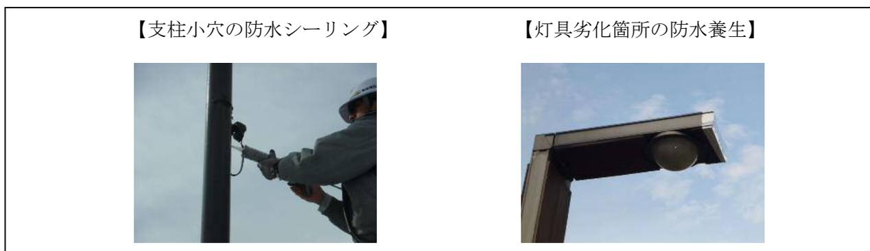
写真-1 損傷進行を抑える対策事例
