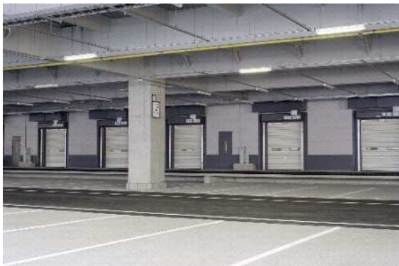
仲卸業者の荷物の積込場 (トラックパースとシャッター完備)
