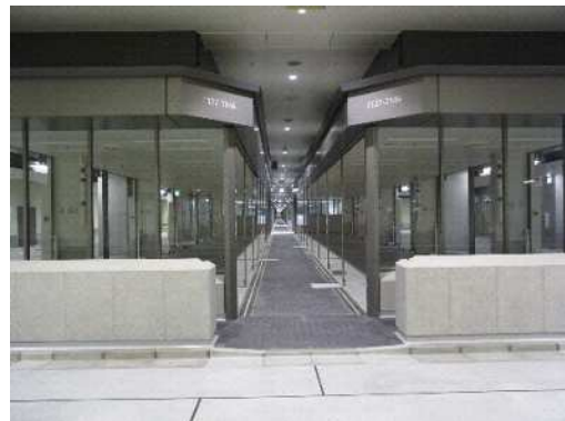
仲卸積込場(トラックパースとシャッター完備)
