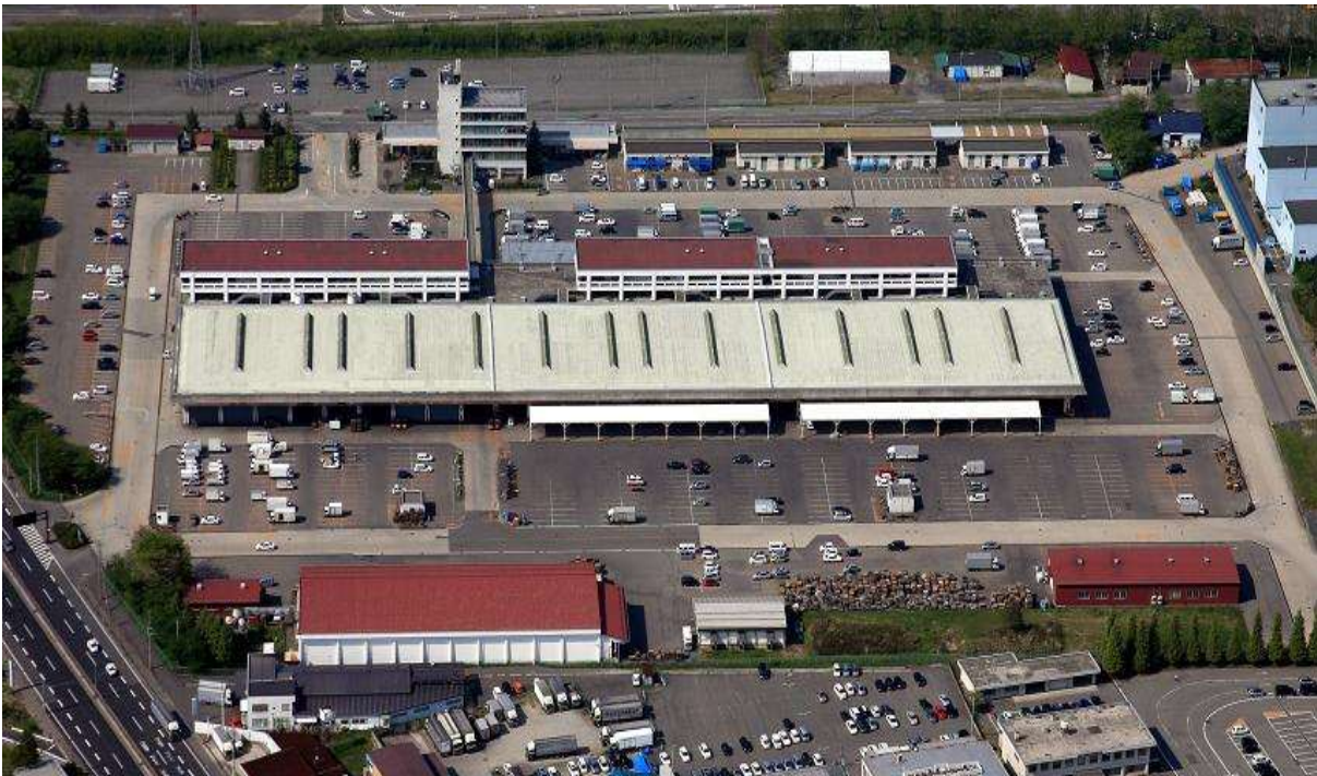
山形市公設地方卸売市場全景
