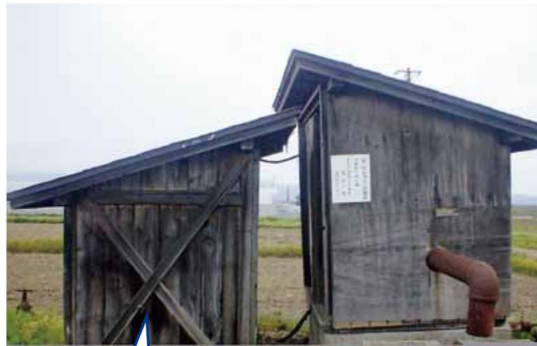
① 左側の小屋は地盤と共に沈下し、右側の小屋は井戸にこつていて抜け上がった状態。
