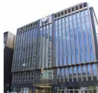
↑山形商工会議所会館新館（平成21年）
