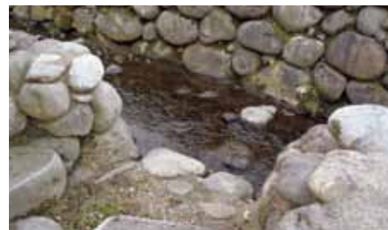
④堰と洗い場
