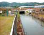
↑用水路トンネル出口
