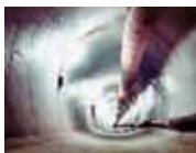
↑西部幹線トンネル
