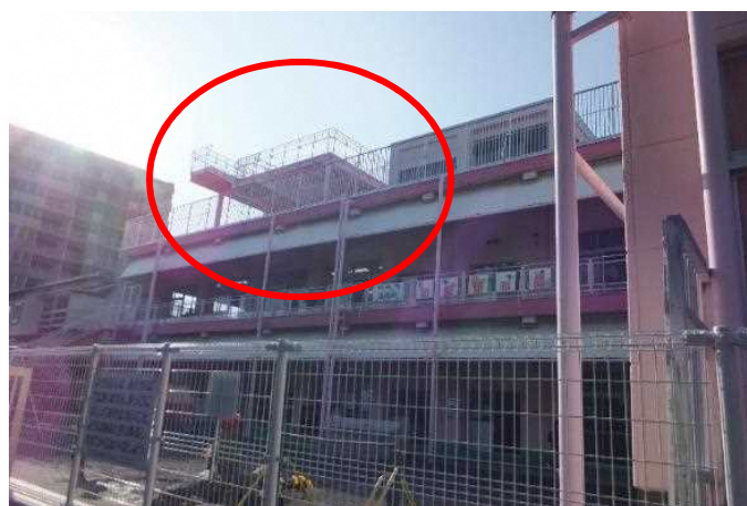
図 15 屋上への避難場所を増築した事例
