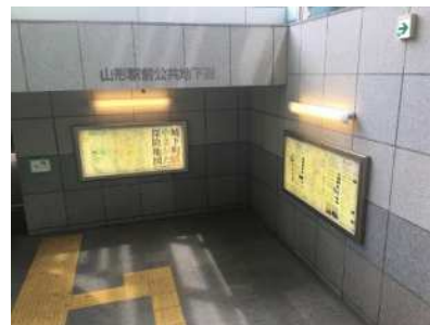
<山形駅前公共地下道>
