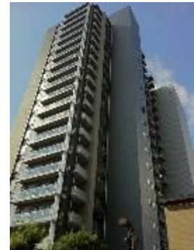
七日町第6ブロック地区 優良建築物等整備事業
