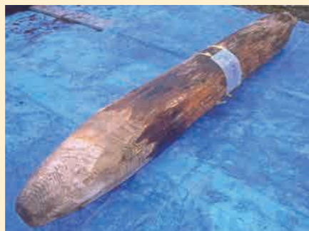
取上げた当時の橋脚 (木柱の先端が削られている)
