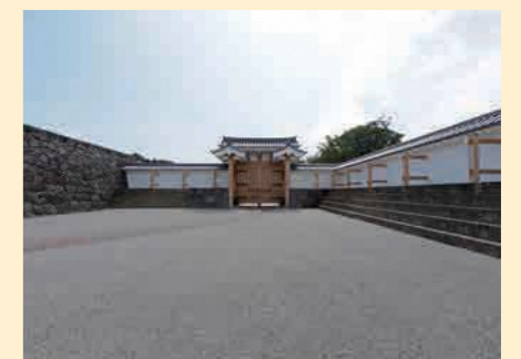
高麗門と桁形土塀完成状況
