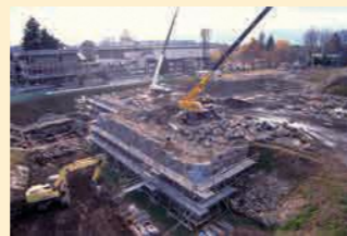
石垣復原工事状況 (北東から)
