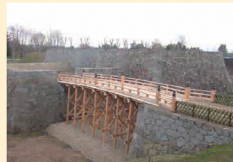
大手橋及び石垣完成状況 (平成17年度時点)
