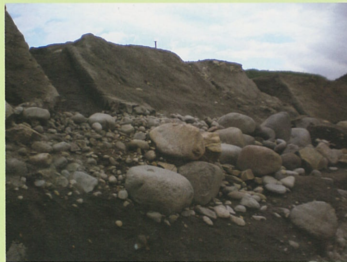
土塁中段石積遺構 (本丸南土塁) 石は自然礫をもちい、長い面を横に配置した2段の石積みです。小礫による裏込めがあり、土留めの役割と考えられます。この石積は土塁築造により削られており「最上氏」時代の遺構と推測しています。
