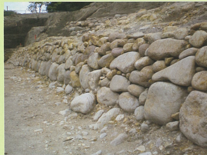
護岸石垣 (本丸南土塁) 石は自然礫で拳〜頭ほどの大きさの石を高さ約 1mに積み上げています。水堀の深さにあたり、二ノ丸堀にも現存します。部分的に石積みが前後二重となっていたり、崩れてなくなっている部分もあることから補修が繰り返されたと考えています。この石垣は土塁築造によりつくられたもので「鳥居氏」時代以後の遺構で幕末まであった石垣と考えています。
