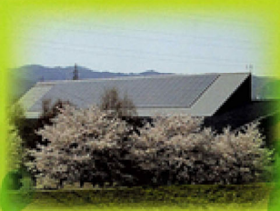
屋内多目的コートの屋根には大きなソーラーパネルがついていて、たくさんの電気をつくっています。
