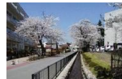
六小東通りせせらぎ水路
