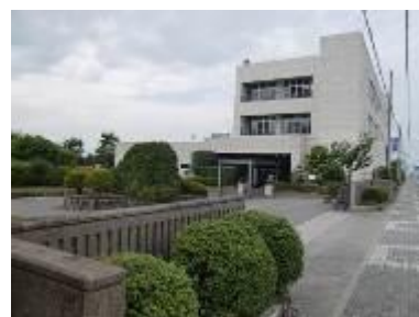
浄化センター
