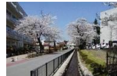
六小東通りせせらぎ水路
