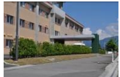
大規模建築物等届出制度活用による緑化 (沼木地内)
