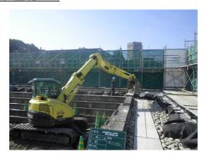
控え柱の土台となるコンクリート基礎 を設置し、いよいよ組み上げる準備が整い ました。
